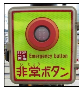
踏切支障報知装置
