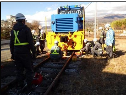
・ MC 車脱線復旧訓練
